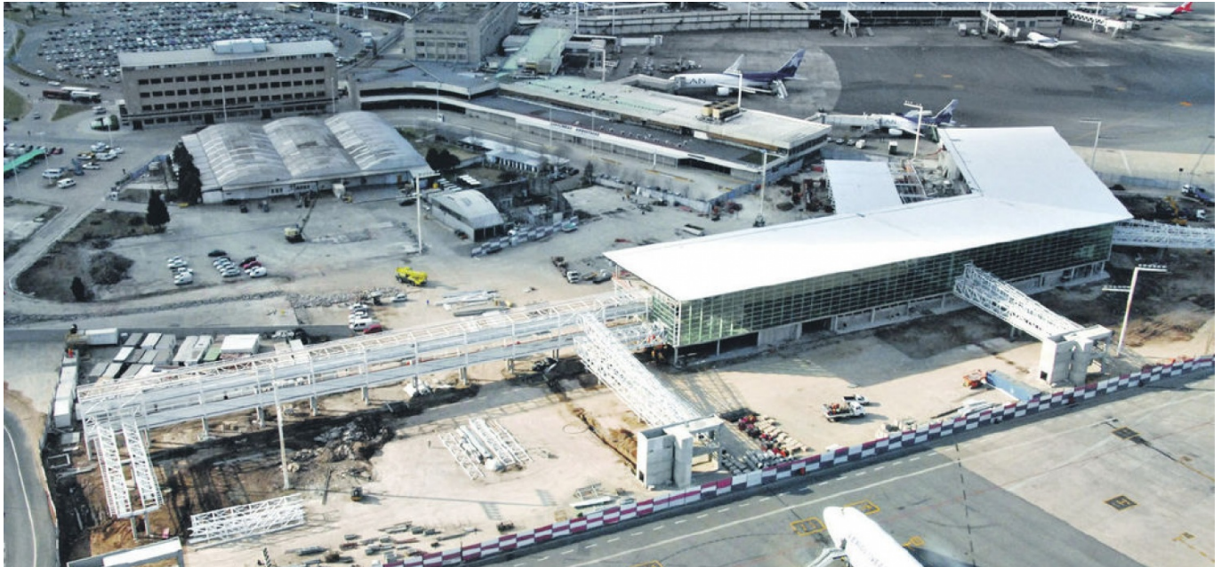
Edificio para la Nueva Terminal del Aeropuerto Ministro Pistarini.
